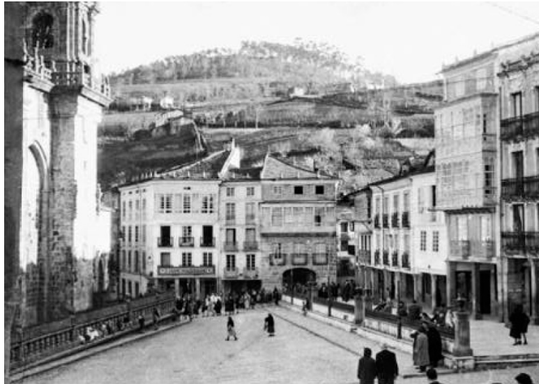
Imagen de la Plaza y del Cantón Grande antes de la reforma
